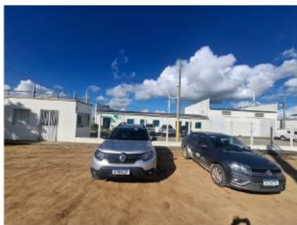
Figura 3 - Escritório da Eólica Serra das Vacas (O&M)
